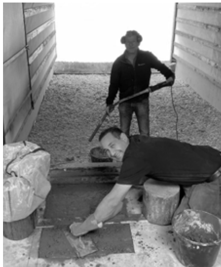
Rolf Tamber (nærmest) og Arne Ånneland støper fundament på 100m for testbenk.
