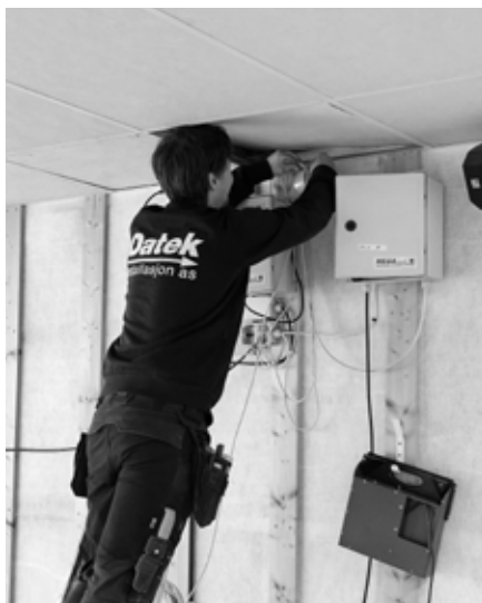
Et nødvendig bytte av kabel på 15m
